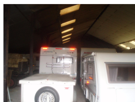
Foto 5 varkensstal die gesloopt wordt, tegenwoordig in gebruik als caravanstalling
