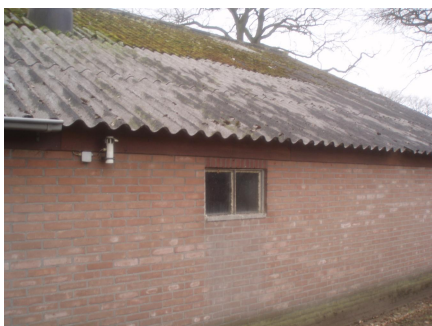
Foto 2 één van de te slopen varkensschuren
