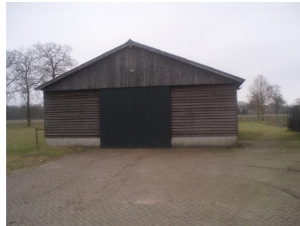
Foto 3 Schuur die eveneens gesloopt wordt
