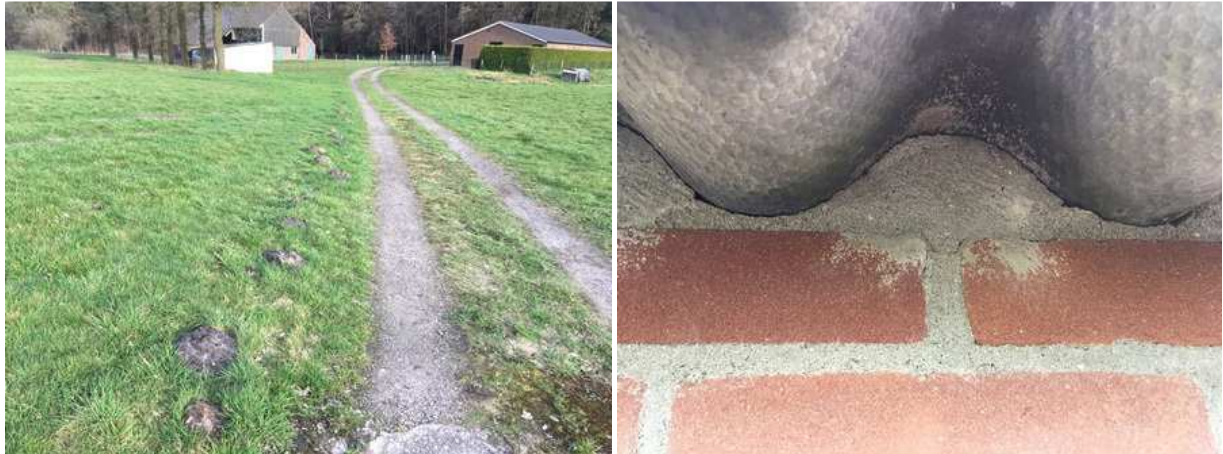
Foto links; molshopen in het plangebied. Aanwijzing op de aanwezigheid van de soort. Foto rechts; door het afdichten van openingen onder golfplaten kan de steenmarter niet tussen de dakisolatie en de golfplaten kruipen.
