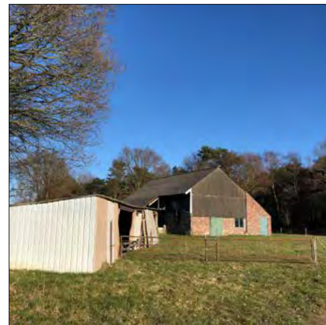
te slopen schuren
