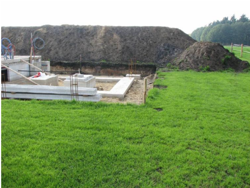
Foto 2: Overzichtsfoto van de nieuwbouwlocatie.
