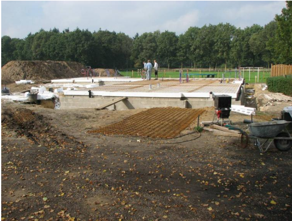
Foto 1: Overzichtsfoto van de nieuwbouwlocatie.
