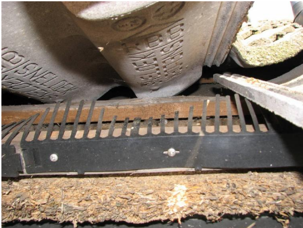
Foto 10: Ter plaatse van het woongedeelte zijn de open ruimten onder de dakpannen afgedicht met roosters, waardoor de huismus geen toegang heeft tot nestlocaties.
