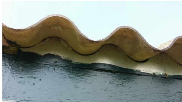
Figuur 12. De dakrand van de vervallen schuur is afgedicht.
