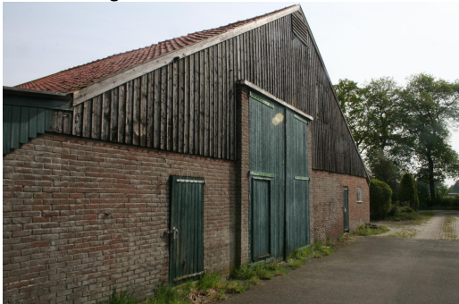
Te slopen schuur
