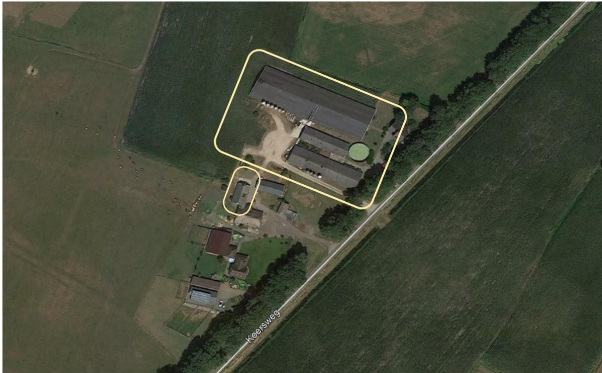
Figuur 5: Overzicht van de onderzochte locatie. Te slopen delen in geel kader. Bron: Google Maps.
