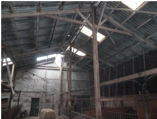
Afbeelding 1: de te slopen veeschuur.
