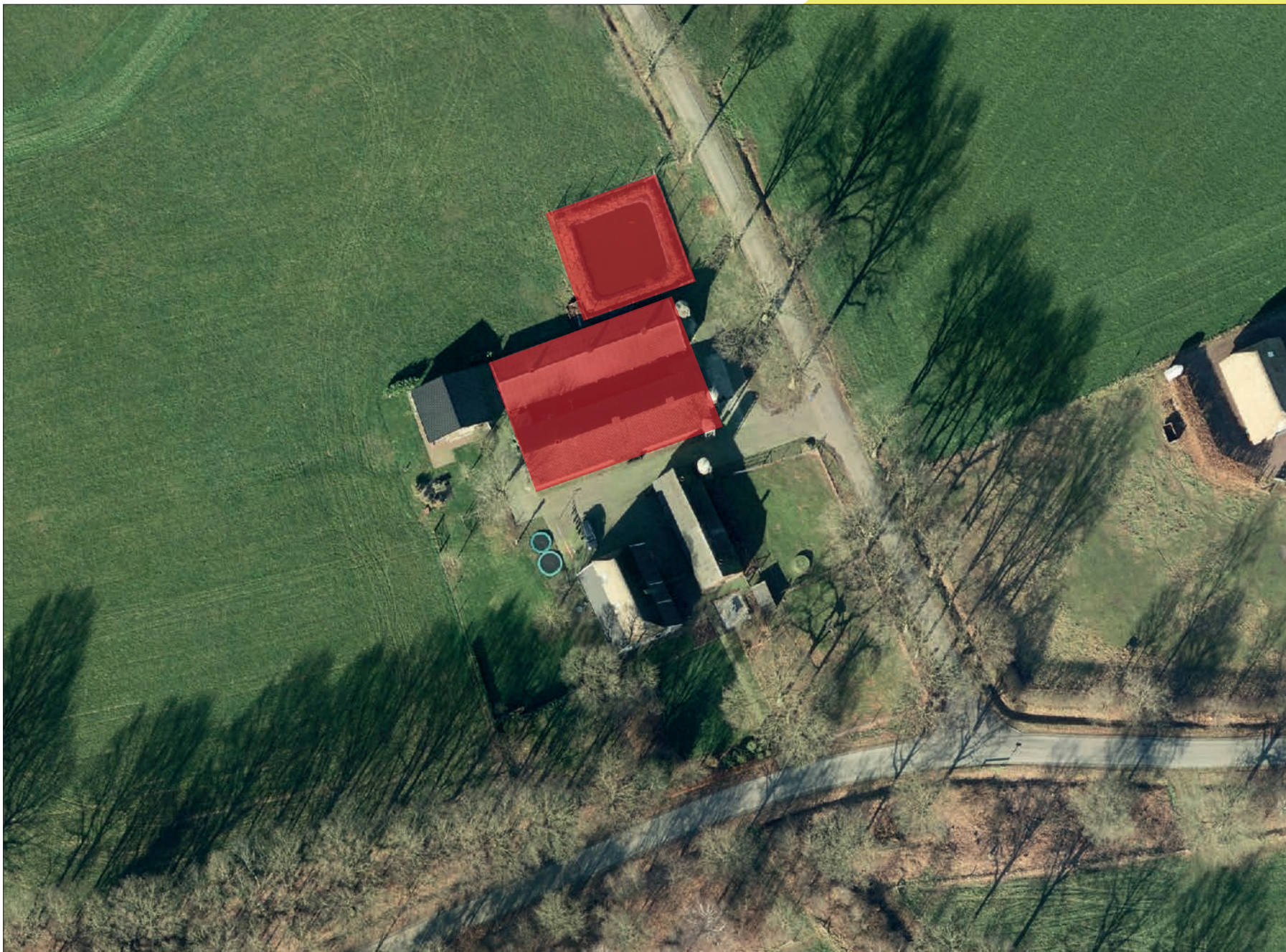
overzicht te slopen opstallen Helhuizenweg 16 Haarle
