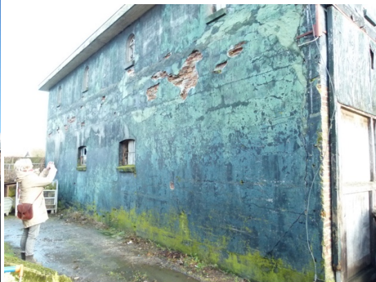
De kopse gevel van de jongere loods.
