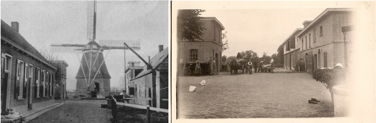
Links: Zicht op de molen langs de bakkerij (rechts) met daarachter een bedrijfsgebouw en linksachter de loods. Rechts: hetzelfde zicht een aantal jaar later. Het bedrijfspand (rechts) staat vrij na de sloop van het pand ervoor en de molen. links de loods langs het kanaal, die inmiddels is uitgebreid met een net iets hogere en langere loods erachter (foto tussen 1936 en 1940).
