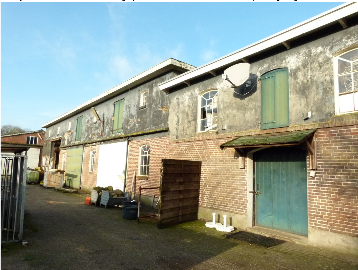
Zuidgevels van de opslagloodsen.
