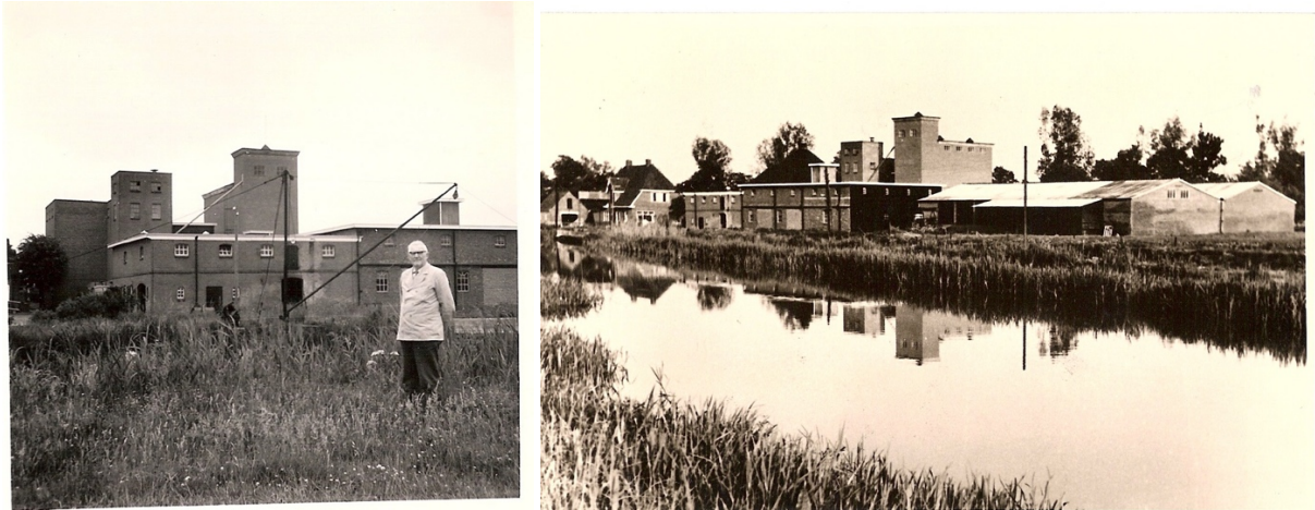
Links: de twee loodsen langs het kanaal met erachter de kleine silo uit 1940 en rechts achter nog een tweede, grotere silo, foto circa 1960. De grote openingen in de jongere loods zijn al dichtgezet. Rechts: aanzicht vanaf de Kanaalweg noordzijde.
