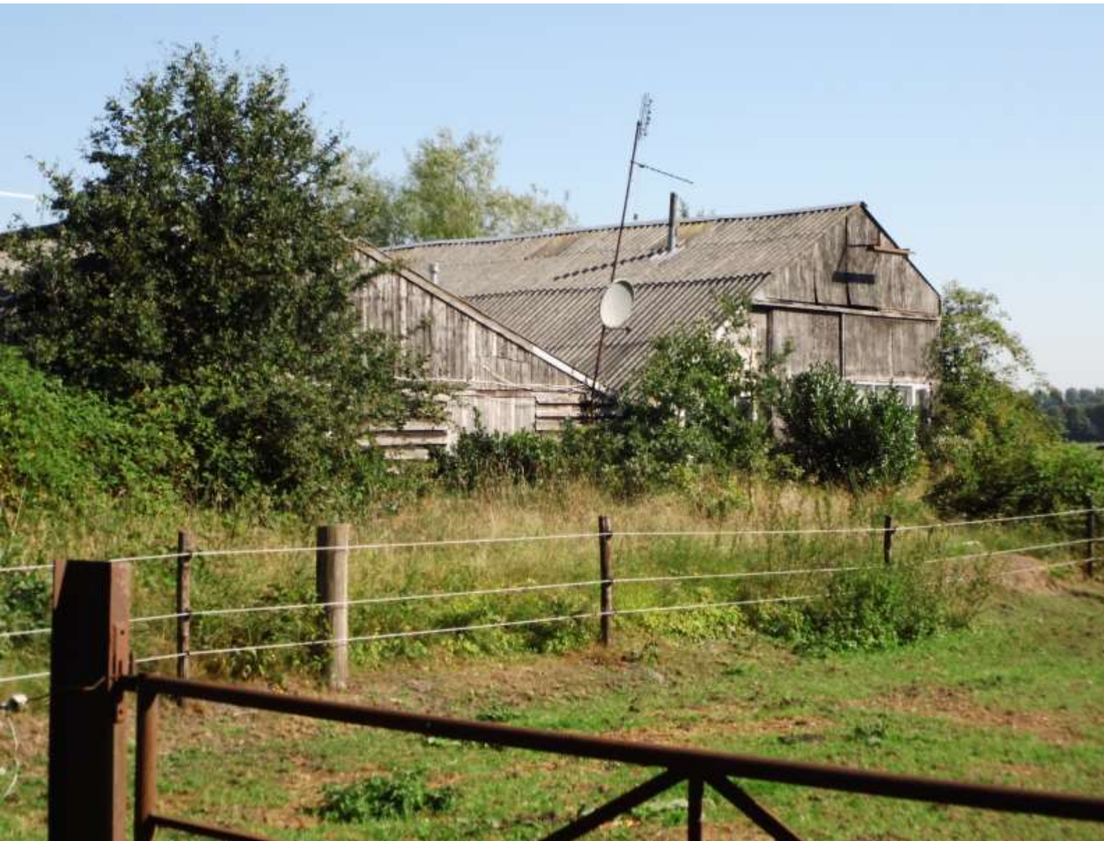
Foto 1. De te slopen opstallen aan de Esweg 19b te Daarle.
