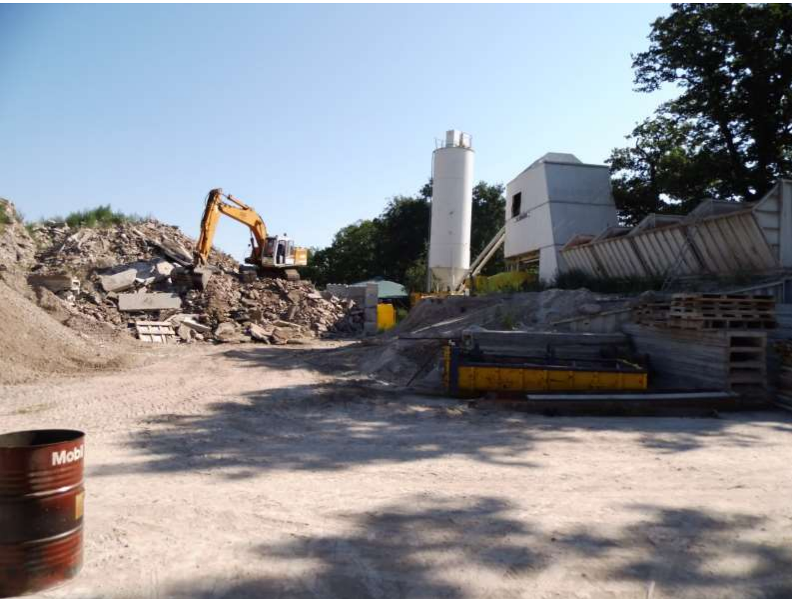
Foto 2. Het te ontmantelen puinverwerkend bedrijf.
