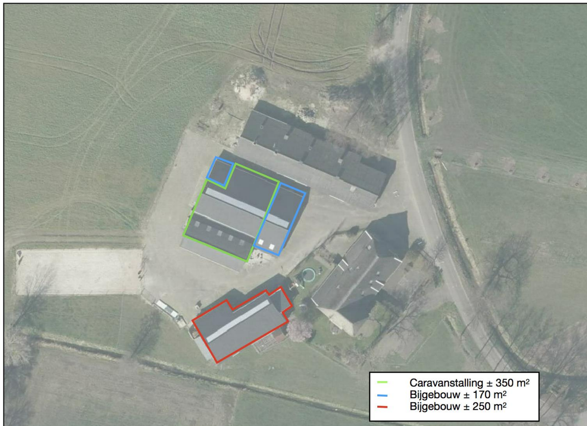
Afbeelding 3.1 Te behouden schuur (Bron: Provincie Overijssel, bewerking BJZ.nu)
