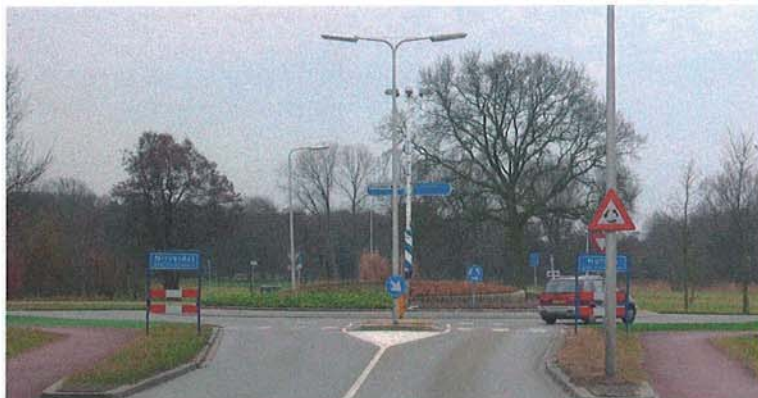
Figuur 12: Rotonde Helmkruidlaan, begin/eindpunt van het te onderzoeken tracé
