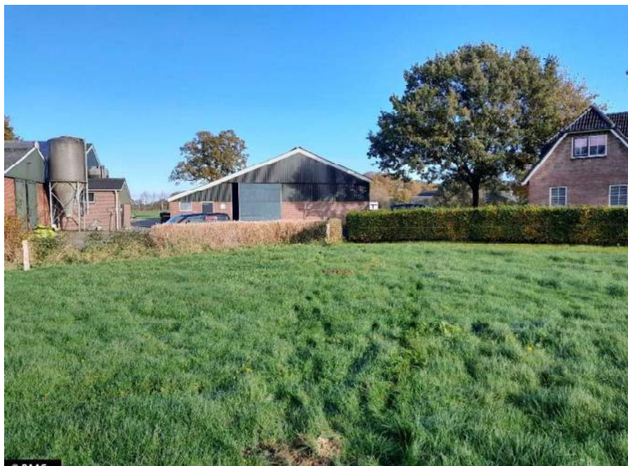
Afb. 3.2 Zicht op de nieuwbouwlocaties gezien vanaf het zuiden, met op de voorgrond boring 1. (d.d. 16-11 2023).
