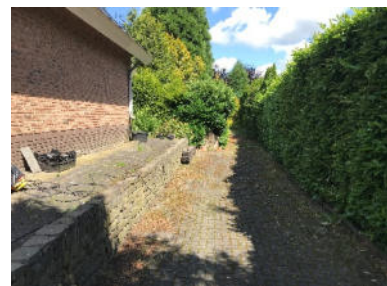
foto 3 - ter plaatse van asbestgat G1
