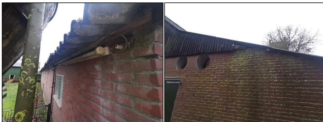
Figuur 2.9 (links): De dakbedekking van de varkensstal vertoont ruime openingen tussen de muur en dak; Figuur 2.10 (rechts): Gat in de daklijst van de voormalig varkensstal. Een zwarte smeervlek onder een van de grote gaten in de gevels, vermoedelijk door marters.
