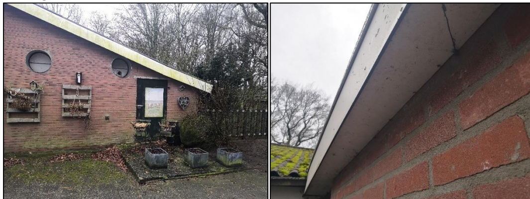
Figuur 2.3 (links) en 2.4 (rechts): Impressie van de stal en de daklijst.
