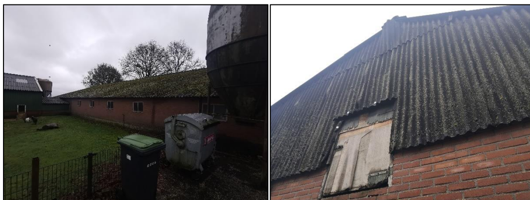
Figuur 2.7 (links): Impressie van de kleine wei met aangrenzende stallen; Figuur 2.8 (rechts): Impressie van de voorgevel van de voormalig varkensstal. Deze geeft een verouderde indruk en heeft ruime openingen en tochtgaten.
