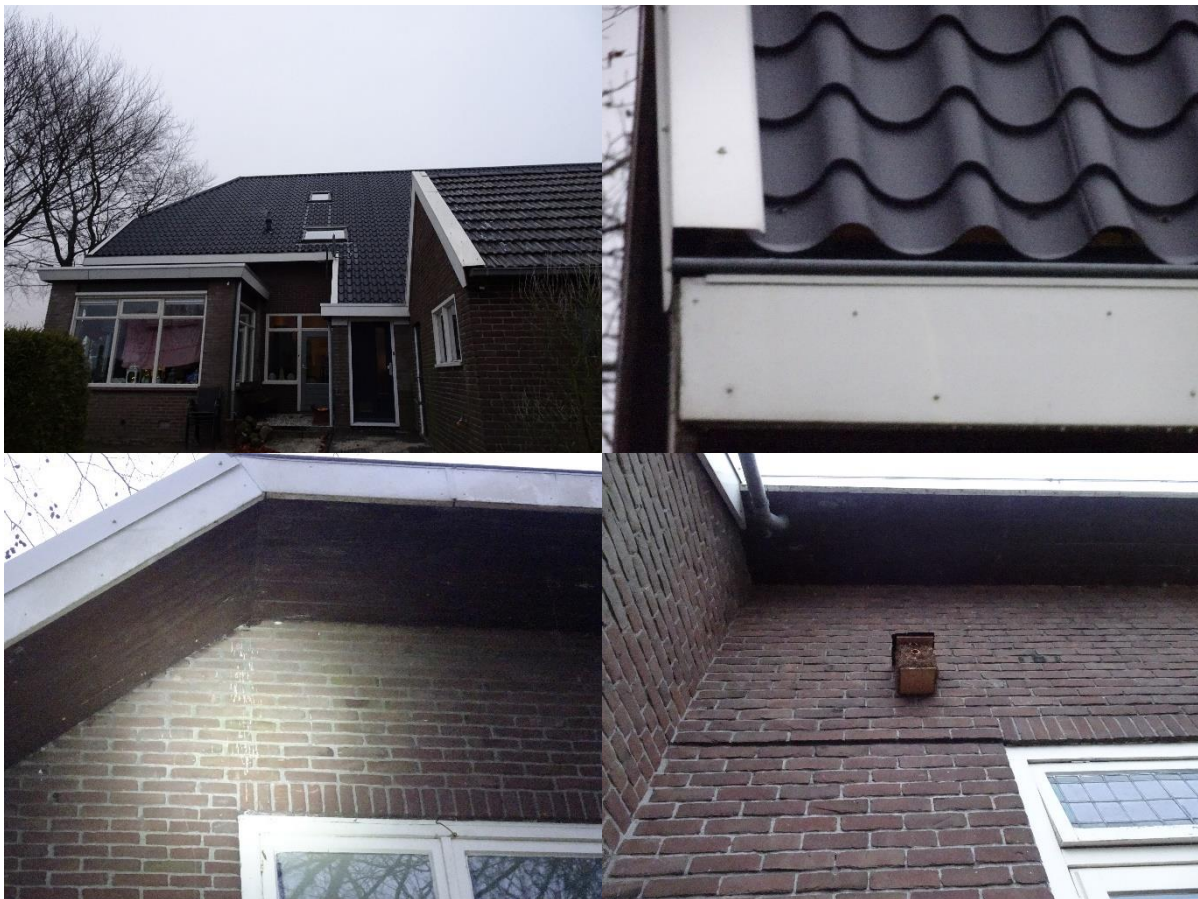
Figuur 5 Potenties voor vogels op het terrein aan de Zestiende Wijk 15 te Dedemsvaart. Boven: Dakconstructie van het woonhuis (dakpanplaten). Linksonder: poepsporen van vogels (mogelijk spreeuw) die een poging hebben gedaan om achter de betimmering te kruipen. Rechtsonder: vogelhuisje aan de zijgevel van het woonhuis. Onder de dakpanplaten van het woonhuis lijkt wel enige ruimte voor huismussen beschikbaar te zijn. Daar werd ook een huismus in de dakgoot aangetroffen. Foto's: Bureau Biota.
