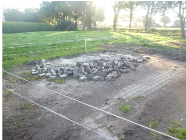
Klinkers en klinkerverharding achter schuur aan de Engeland 1
