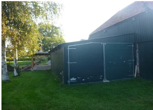
Aanbouw ten noorden van de hooischuur
