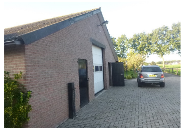
Schuur, ten noordoosten van de woning aan de Engeland 3
