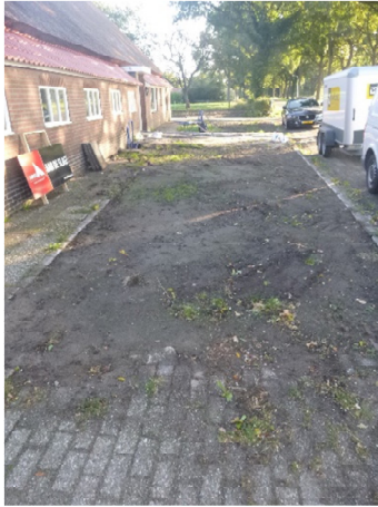
Boerderij aan de Engeland 1, ten zuiden van het perceel
