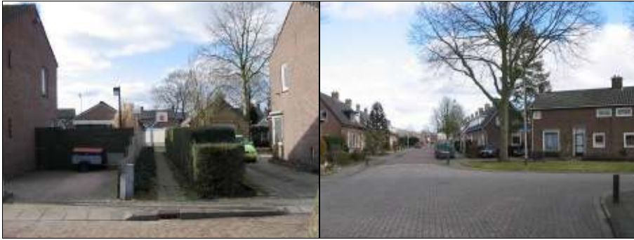
Voetpad naar het binnengebied. Hoek Oranjestraat-Beatrixstraat Het linker bouwblok zal worden gesloopt
