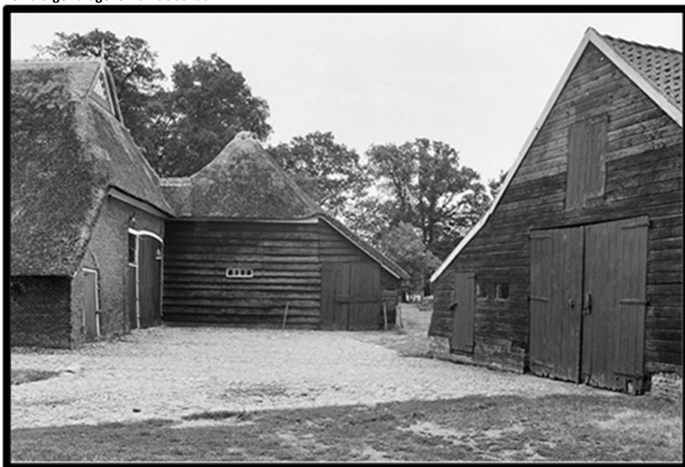
Deze foto uit 1965 geeft de oude uitstraling van de zuidzijde boerderij met de baanderdeuren het gepotdekselde aanzicht van de hoischuur en rechts op de foto de potstal die in de 1981 wegens bouwvalligheid is afgebroken.
