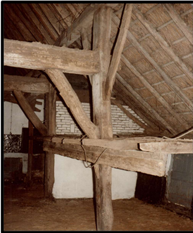
De schuur voor de verbouwing in 1980
