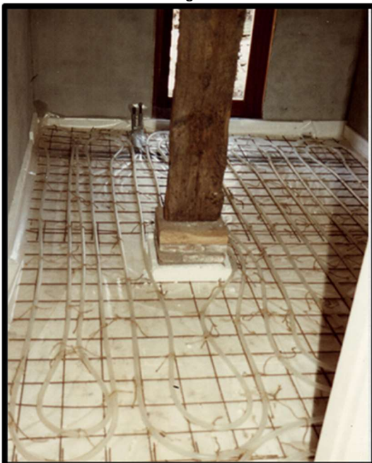
De aangebrachte vloerverwarming met daarover de algemeen aanwezige plavuizen.
