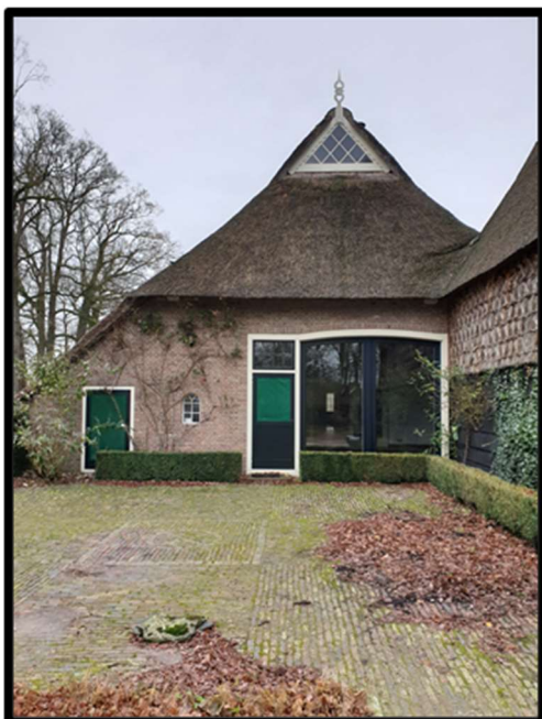
De huidige zuidgevel van de schuur
