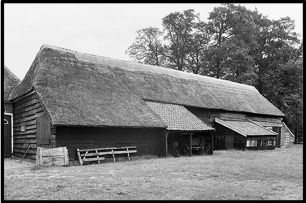
1965 met meerdere met dakpannen gedekte aanbouwen
