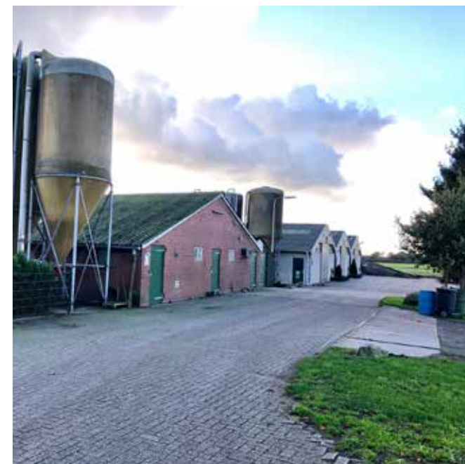
kippenstal met bestaande kalverstal
