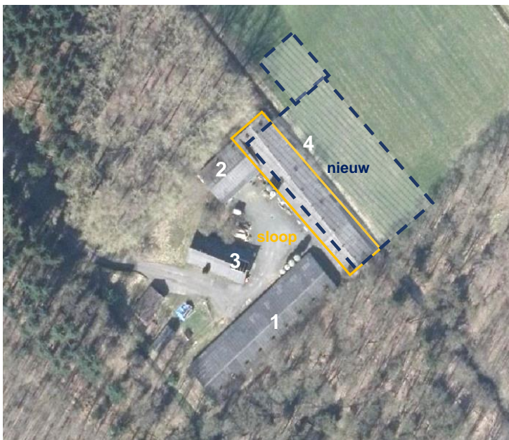
Afbeelding 2: Overzichtsfoto met de te slopen stal en de gewenste situering van de nieuw te bouwen stal.
