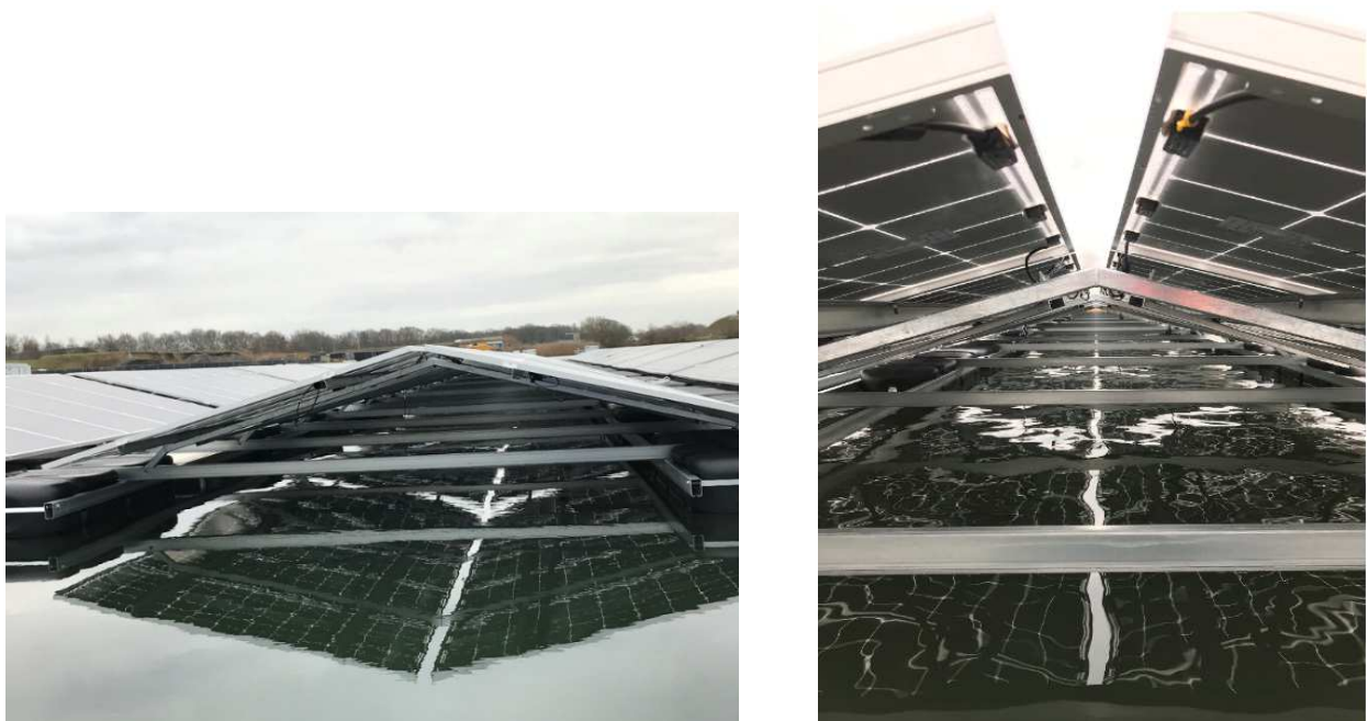
Figuur 3-2: Beschaduwing veroorzaakt door en lichtdoorlatendheid zonnepanelen. Foto's: GroenLeven
