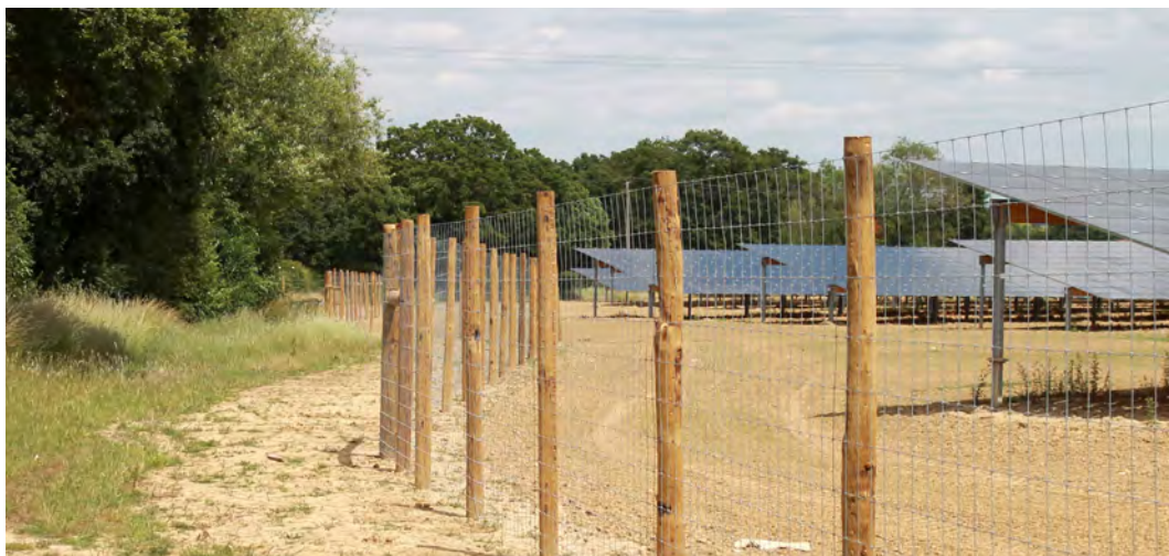
Afbeelding 21. Referentie hekwerk: houten palen en schapengaas (voorkeursvariant)
