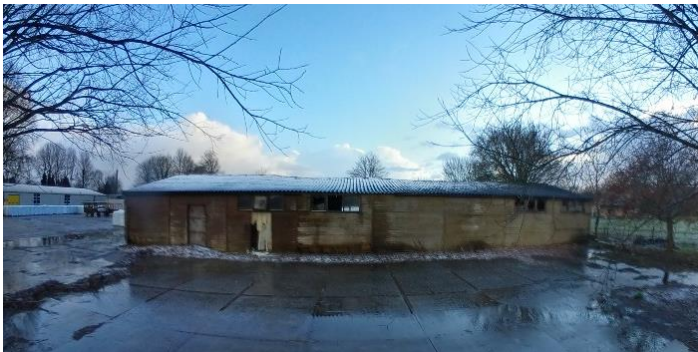
Te slopen bestaande schuur.
