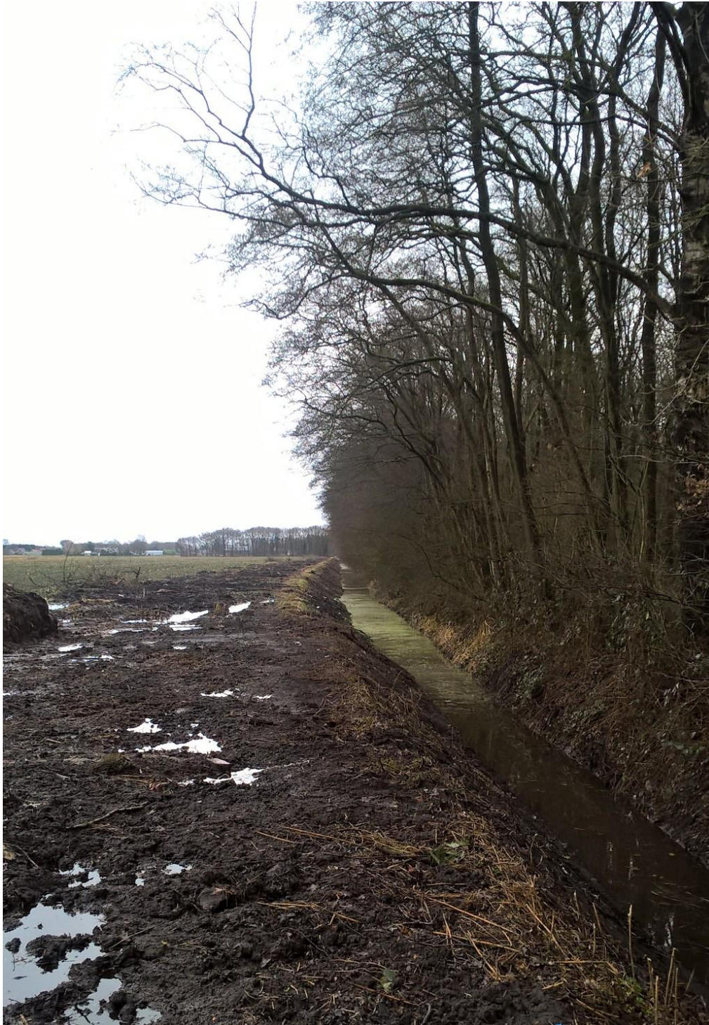
Foto: de Jacobawijk ten zuiden van de Elimmerweg na opschonen, verbreden en herprofiëren.
