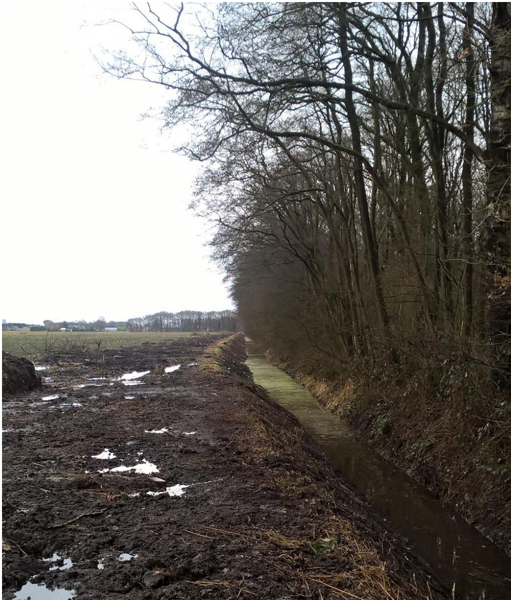
Foto: de Jacobawijk ten zuiden van de Elimmerweg na opschonen, verbreden en herprofiëren.
