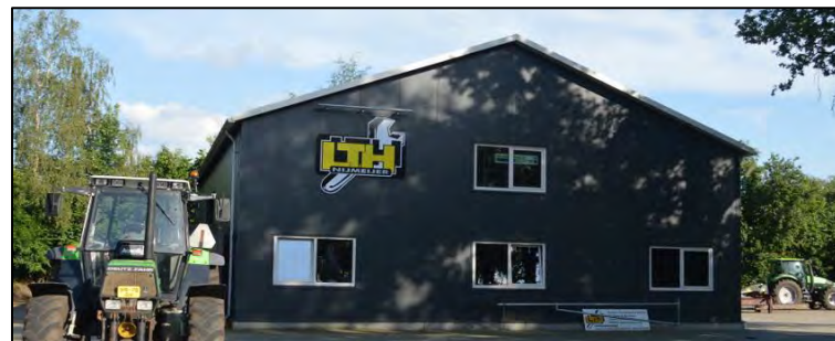
Figuur 9 Bestaande loods
