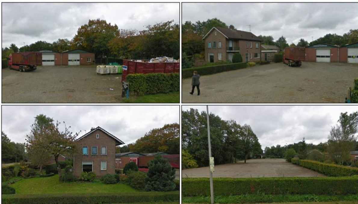
Afbeelding 2.2: Foto's huidige situatie ter plaatse van het plangebied (Bron: Google Streetview)
