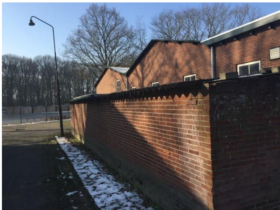
Figuur 6: Overzichtsfoto bebouwing
