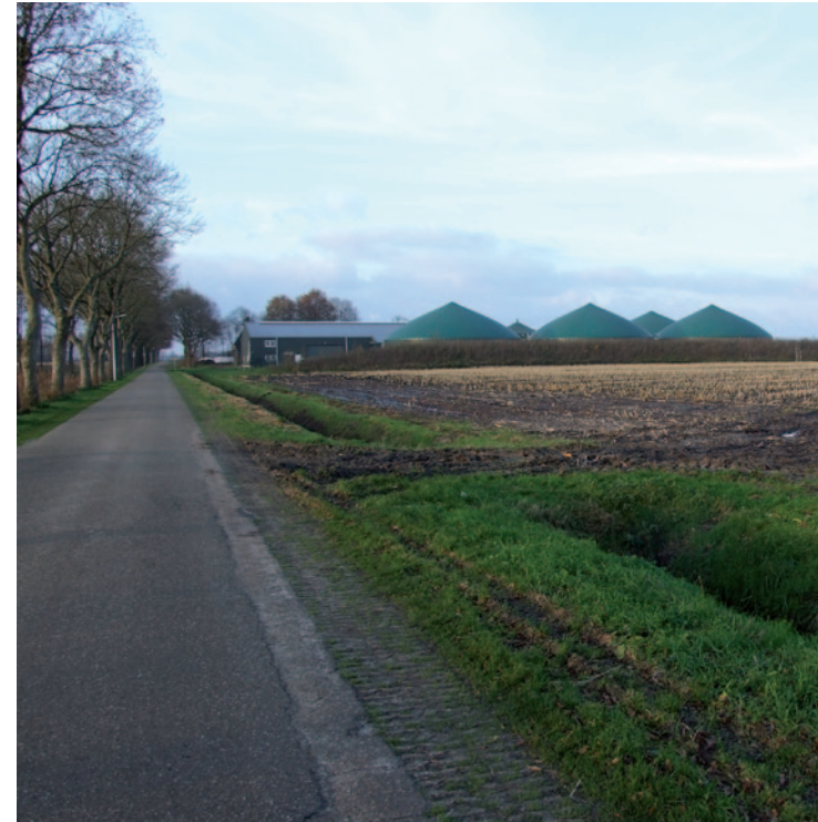
Zicht vanaf Slagenweg op biogasinstallaties
