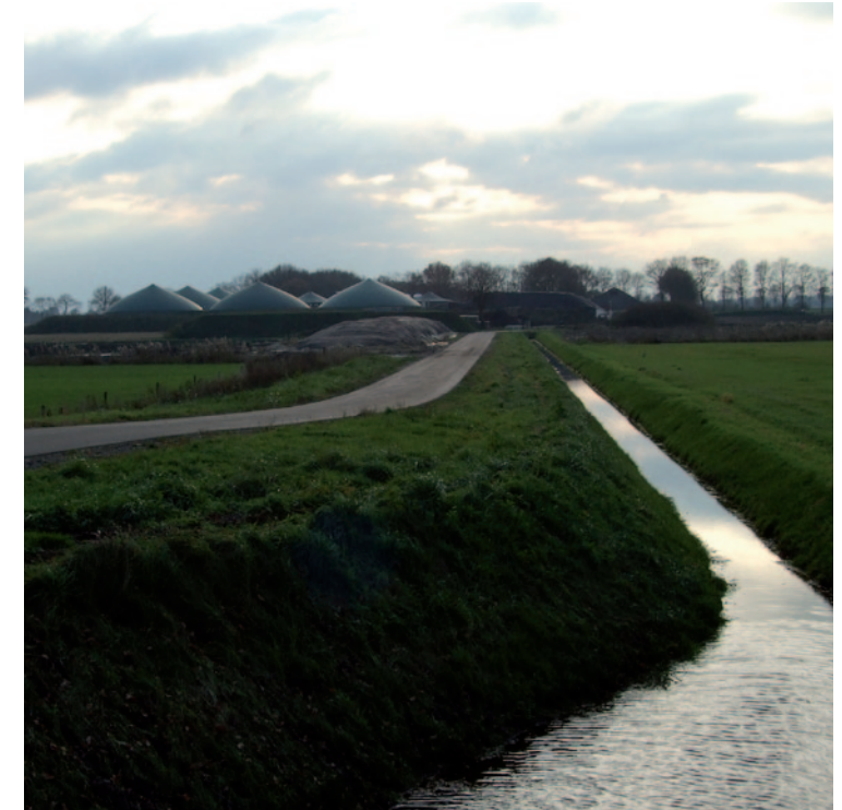
Zicht vanaf de Krimweg op biovergistingsinstallatie
