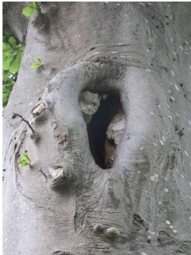
Figuur 5.6. Holte in boom bij modificatie 16, welke in potentie geschikt is als verblijfplaats voor vleermuizen.
