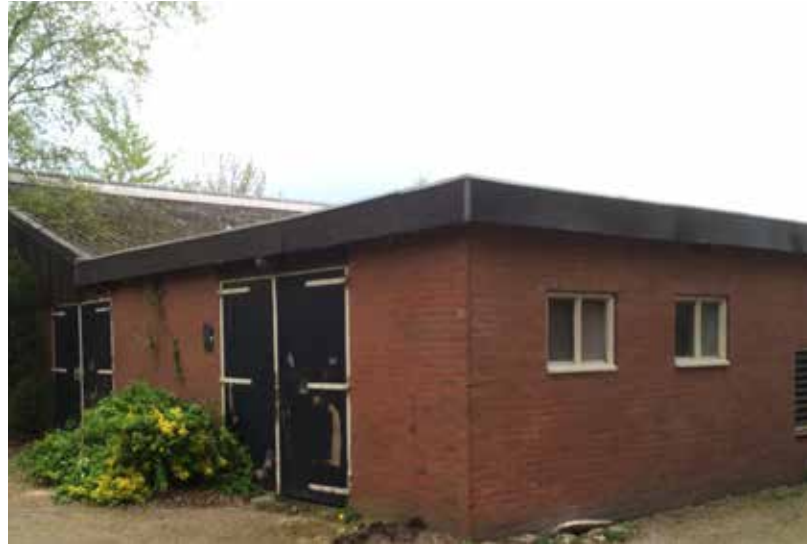
Het aangebouwde deel van de ligboxenstal wordt gesloopt
