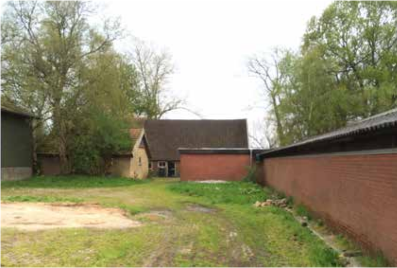
De woning, garage en een deel van de ligboxenstal wordt gesloopt
