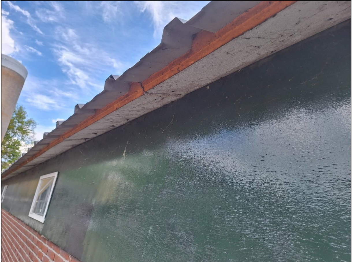
Deel van de gevel van een van de stallen. Delen van het dak sluiten nauw aan op de gevelbekleding.
