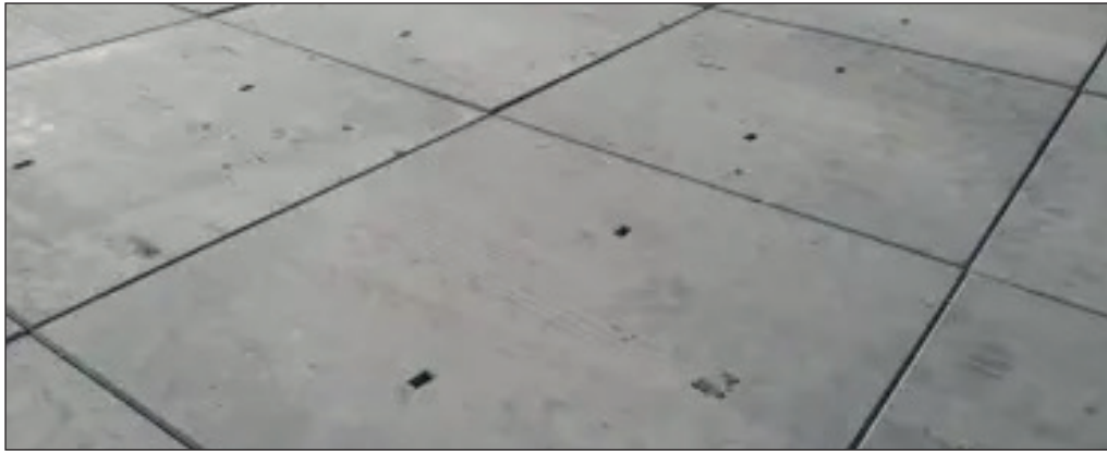
industrieplaat als verharding op het creatieve erf
