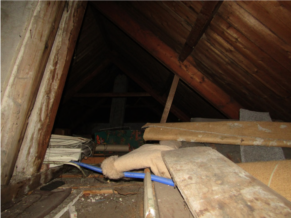
Figuur 5.2: Zolder van de oude woning.
