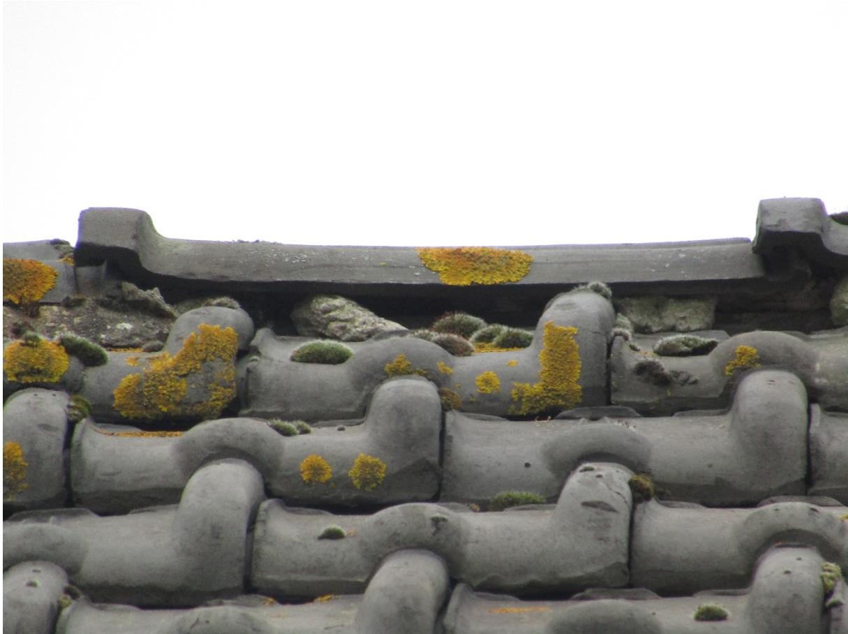
Figuur 5.19: Aanwezigheid van een opening nabij de nok van de oude woning die mogelijk geschikt is als nestlocatie voor de gierwaluw.
