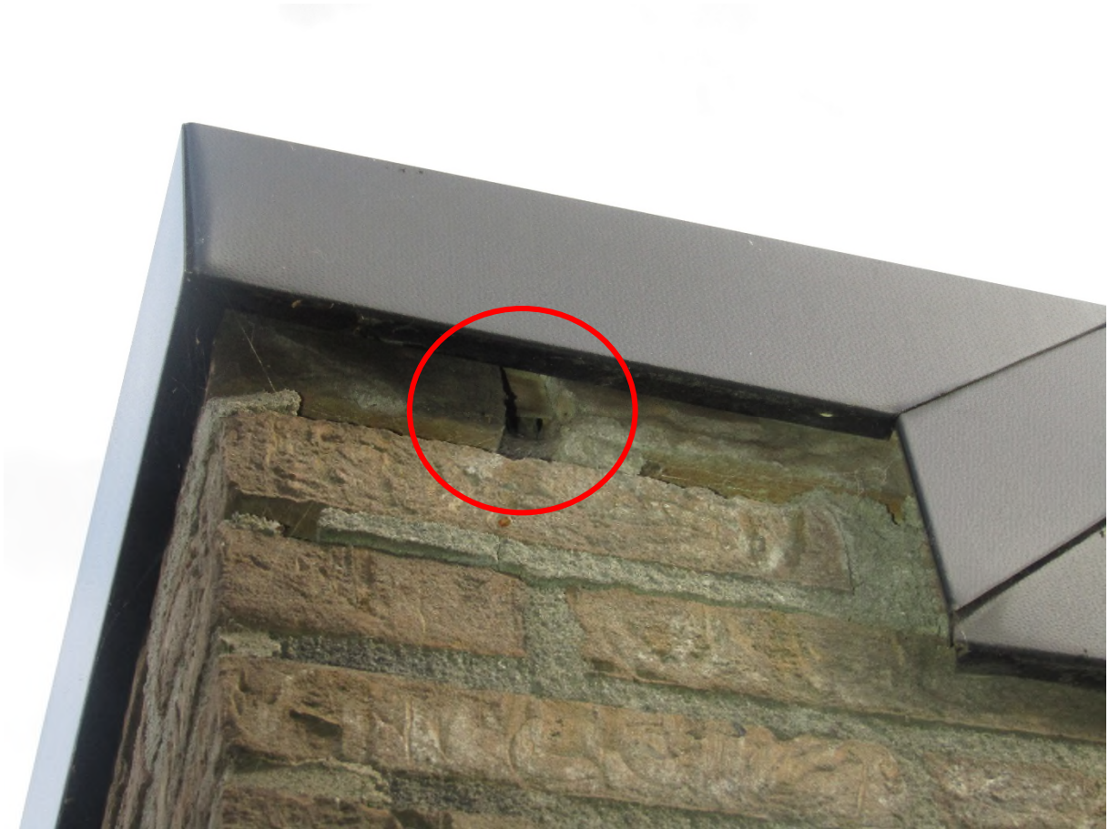
Figuur 5.13: Opening in de spouwmuur van de aanbouw.
