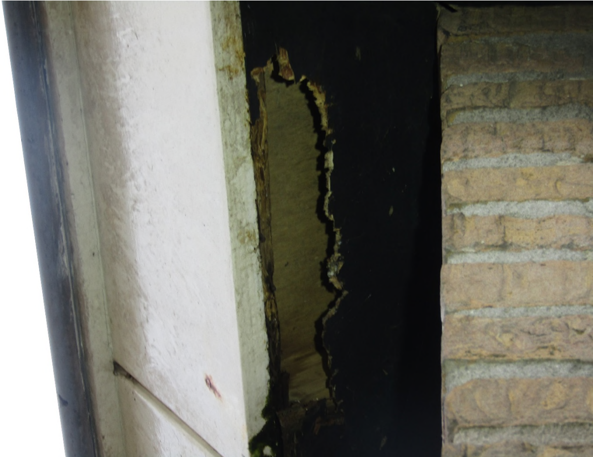
Figuur 5.5: Opening in boeideel van het uitvaartcentrum. Hierbij is een opening aanwezig naar de ruimte onder het dak.
