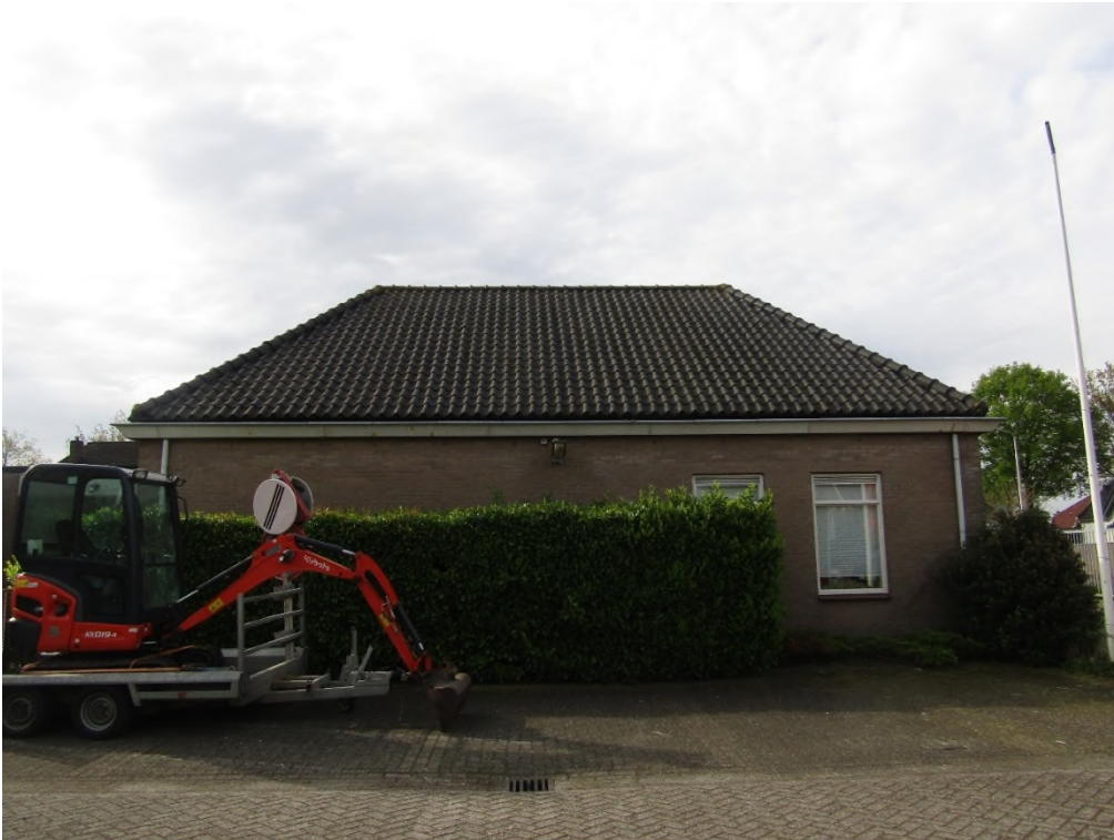
Figuur 3.5: Noordzijde van het plangebied. Gevel aan noordzijde van het uitvaartcentrum met open stootvoegen en grote haag van laurierkers.
