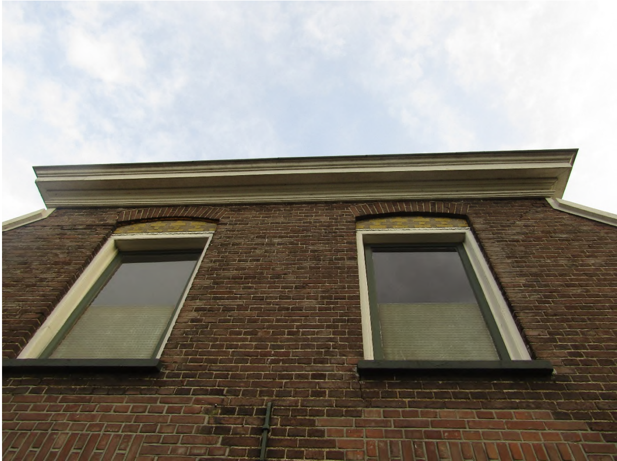
Figuur 5.20: Aanwezigheid van een wit dak overstek aan de voorzijde van het oude woonhuis.
