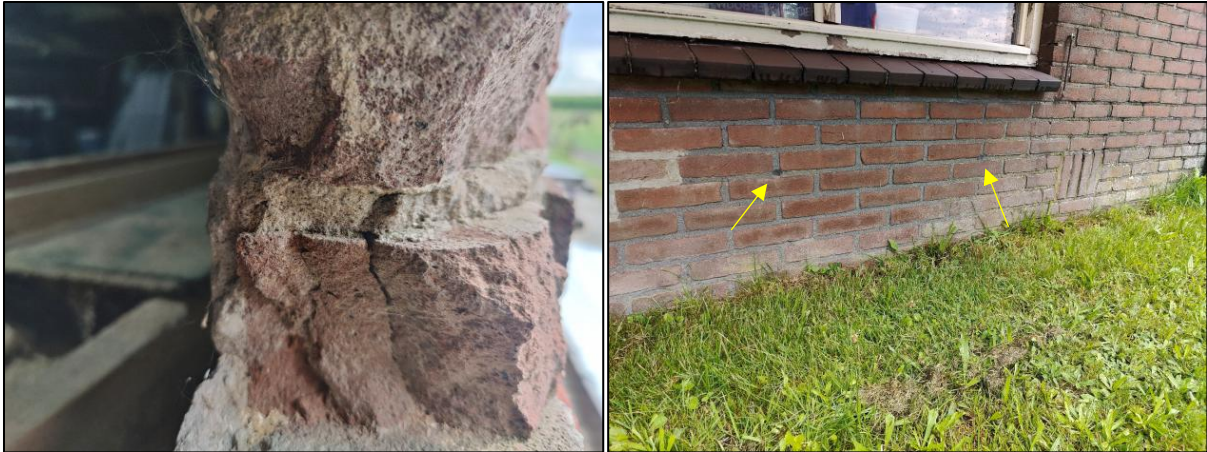
De schuur beschikt over een halfsteens buitengevel (links), de spouwmuur van de woning is nageïsoleerd (rechts).
