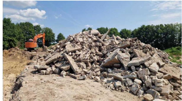
Figuur 14: Sloop bijgebouw
