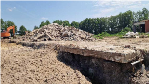
Figuur 13: Sloop bijgebouw
