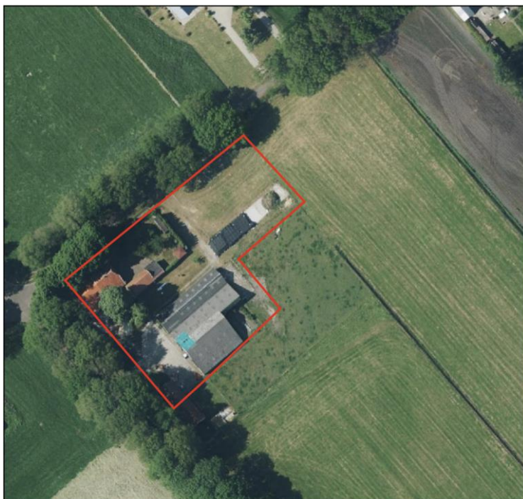
Afbeelding 3.1 Luchtfoto plangebied (Bron: PDOK, bewerkt)
