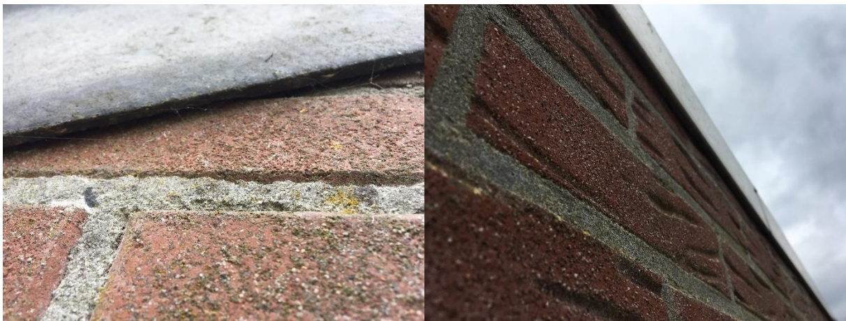
De daklijsten sluiten nauw aan op de buitengevels.
