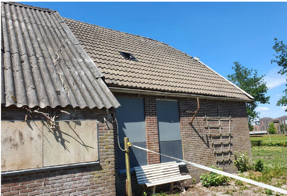
Figuur 5 – Pannendak waar potentiële verblijf- en rustplaatsen van de huismus aanwezig kunnen zijn.
