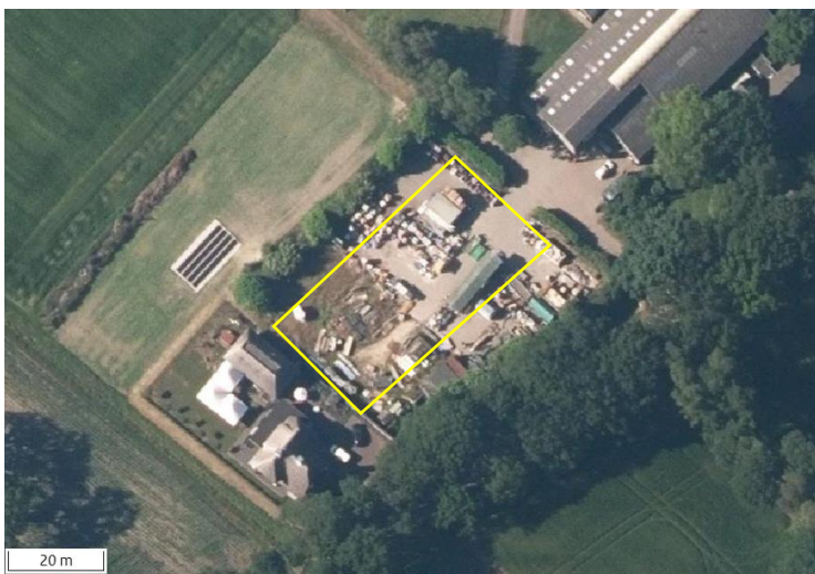
Luchtfoto van het erf waar de loods gebouwd wordt; de bouwplaats wordt aangeduid met de gele lijn (bron luchtfoto: ruimtelijkeplannen.nl).
