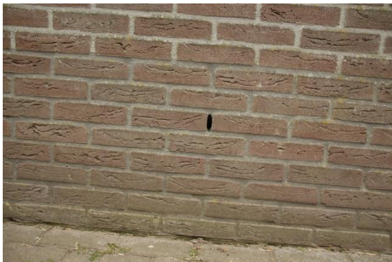
De open stootvoegen op 0,5 meter hoogt vormen geen potentiële invliegopening.
