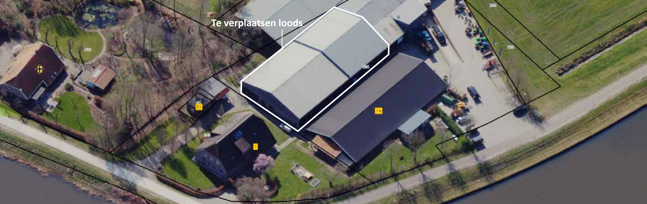
Afbeelding 29. Vogelvluichtbeeld van het erf aan de Kilsseweg 1.
