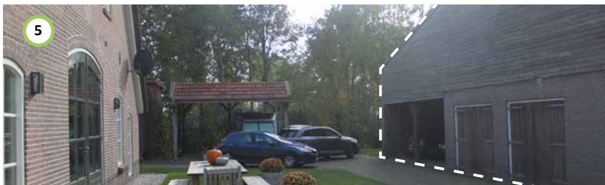
Bestaande loads op huidige locatie wordt verplaatst en betimmerd met hout.
