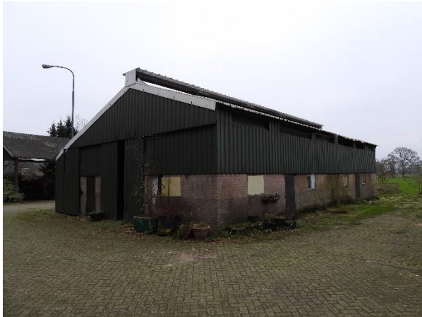
Gebouw met schoon metselwerk tot 2 meter hoogte. Ongeschikt als verblijfplaats voor vleermuizen.
