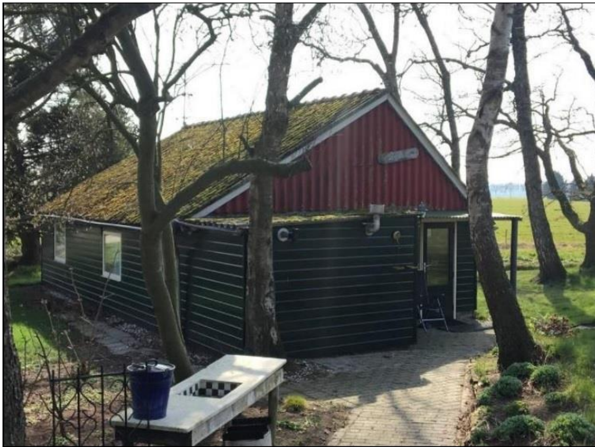
Figuur 2.2 Te slopen recreatiewoning Grote Esweg 6x
