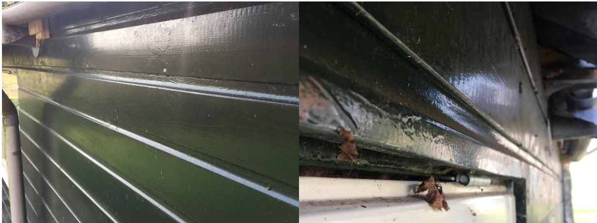
De planken sluiten strak op elkaar aan.
