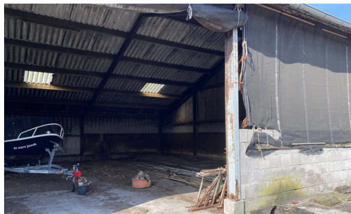
Afbeelding 13. Plaatselijk zijn de damwandplaten beschermd met houten panelen in de kapschuur
