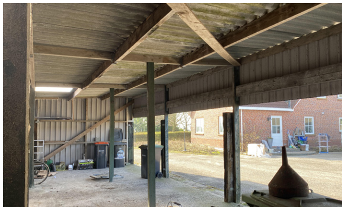
Afbeelding 7. Binnenzijde garage (nr. 2)
