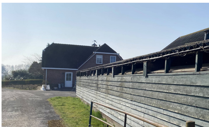
Afbeelding 8. Aanpalende schuur (nr. 3) was een oude loopstal uit 1974
