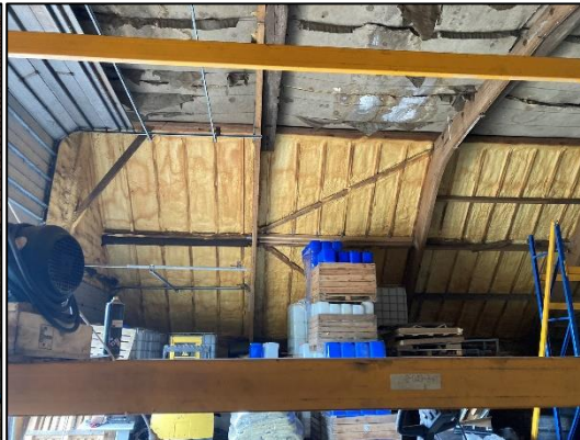
Figuur 2.5 (links): Impressie van de zijkant en het dak, gezien vanaf de oostkant, enkele dakpannen liggen los; Figuur 2.6 (rechts): Impressie van de binnenzijde van het bedrijfspand. Het dak is deels voorzien van een purschuim isolatielaag.
