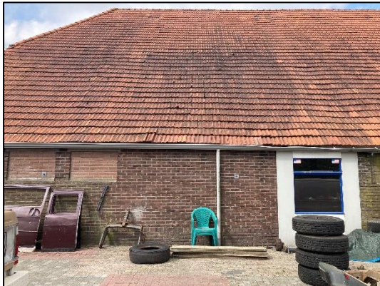
Figuur 2.5 (links): Impressie van de zijkant en het dak, gezien vanaf de oostkant, enkele dakpannen liggen los; Figuur 2.6 (rechts): Impressie van de binnenzijde van het bedrijfspand. Het dak is deels voorzien van een purschuim isolatielaag.
