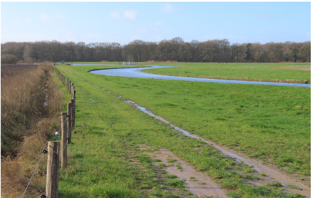
In de afgelopen jaren zijn op enkele andere plekken langs de Vecht, zoals hier bij Stegeren, nevengeulen aangelegd om de rivier een deel van haar oorspronkelijke karakter terug te geven en om meer ruimte te creëren voor perioden met hoogwater (foto: 7 februari 2022).
